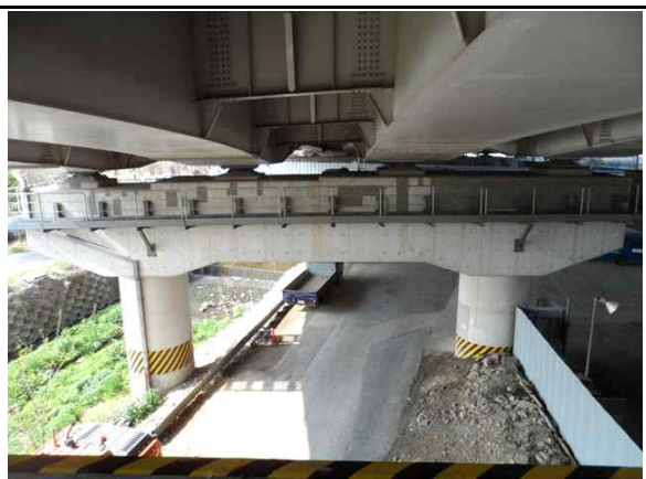
교각 P2 전경
