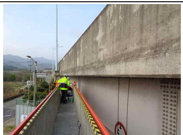
방호벽 외측 전경
