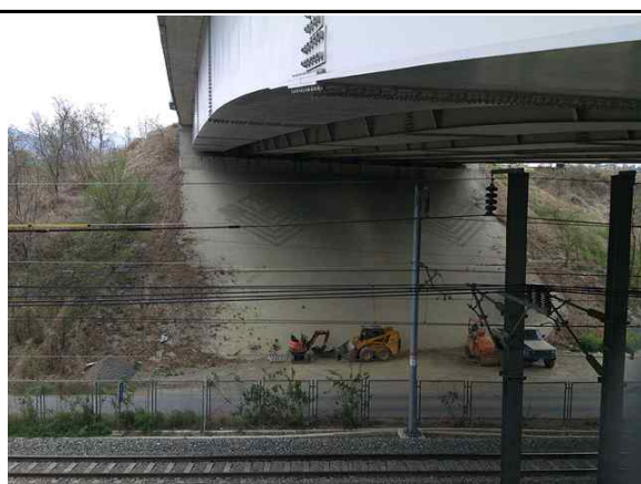
교대 A2 전경
