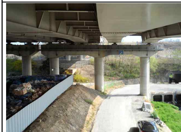
교각 P3 전경
