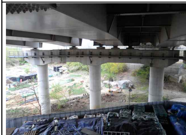
교각 P3 전경
