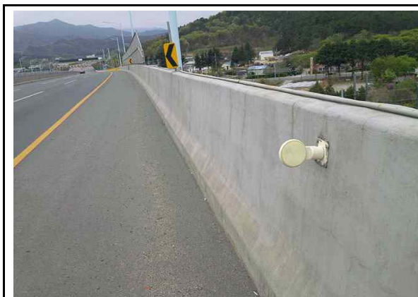
외측 방호벽 및 오물투척 방지망 전경
