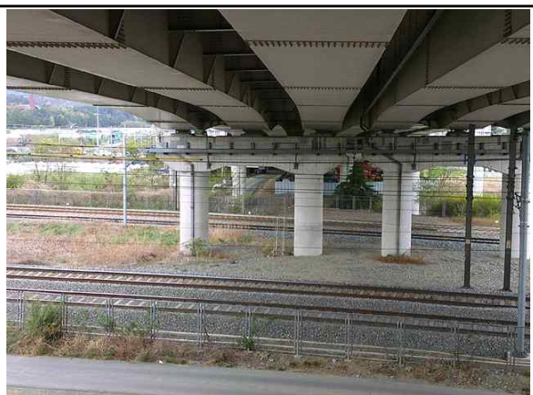
교각 P4 전경
