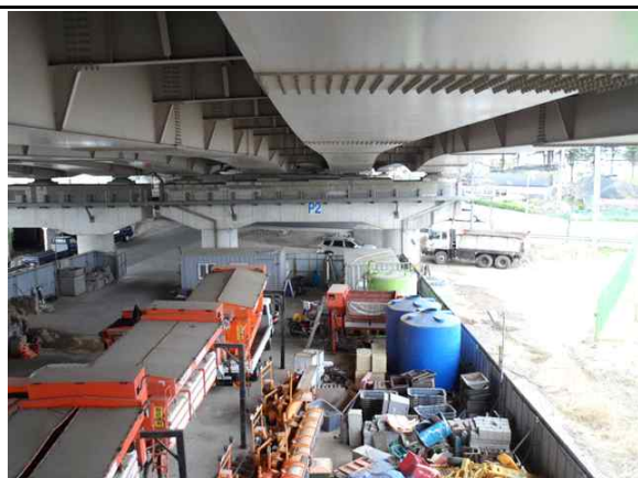
교각 P2 전경
