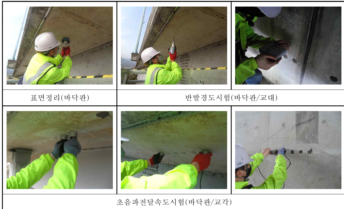
<그림 3.7> 콘크리트 강도조사
