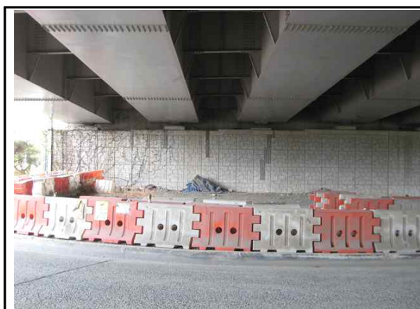
교대 A1 전경
