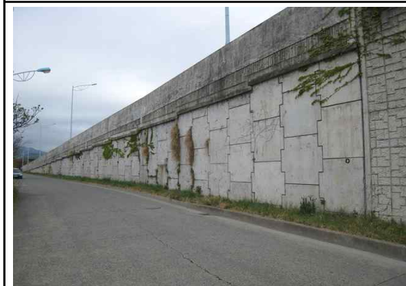
A1 날개벽측 판넬형옹벽 상태양호
