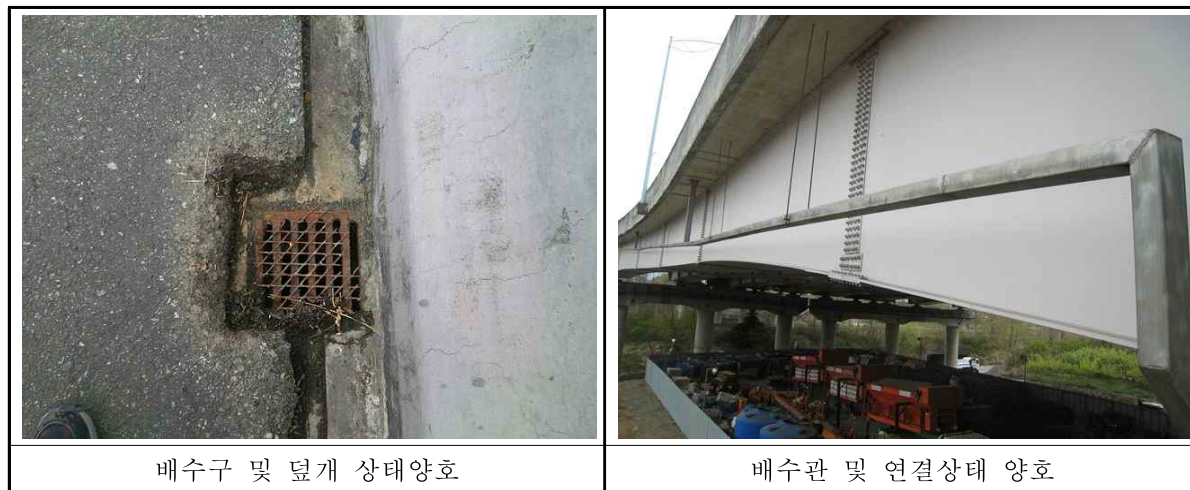
&lt;표 3.24&gt; 범물방향 배수시설 외관조사 결과
