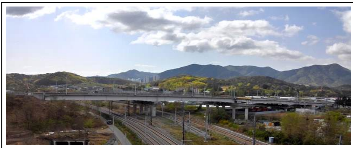
<그림 3.1> 가천교 측면 전경
