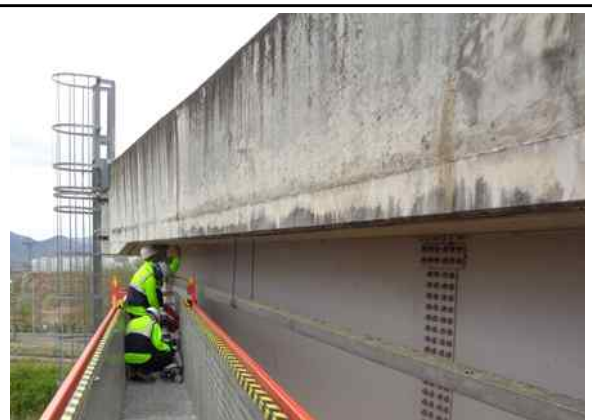
방호벽 외측 전경
