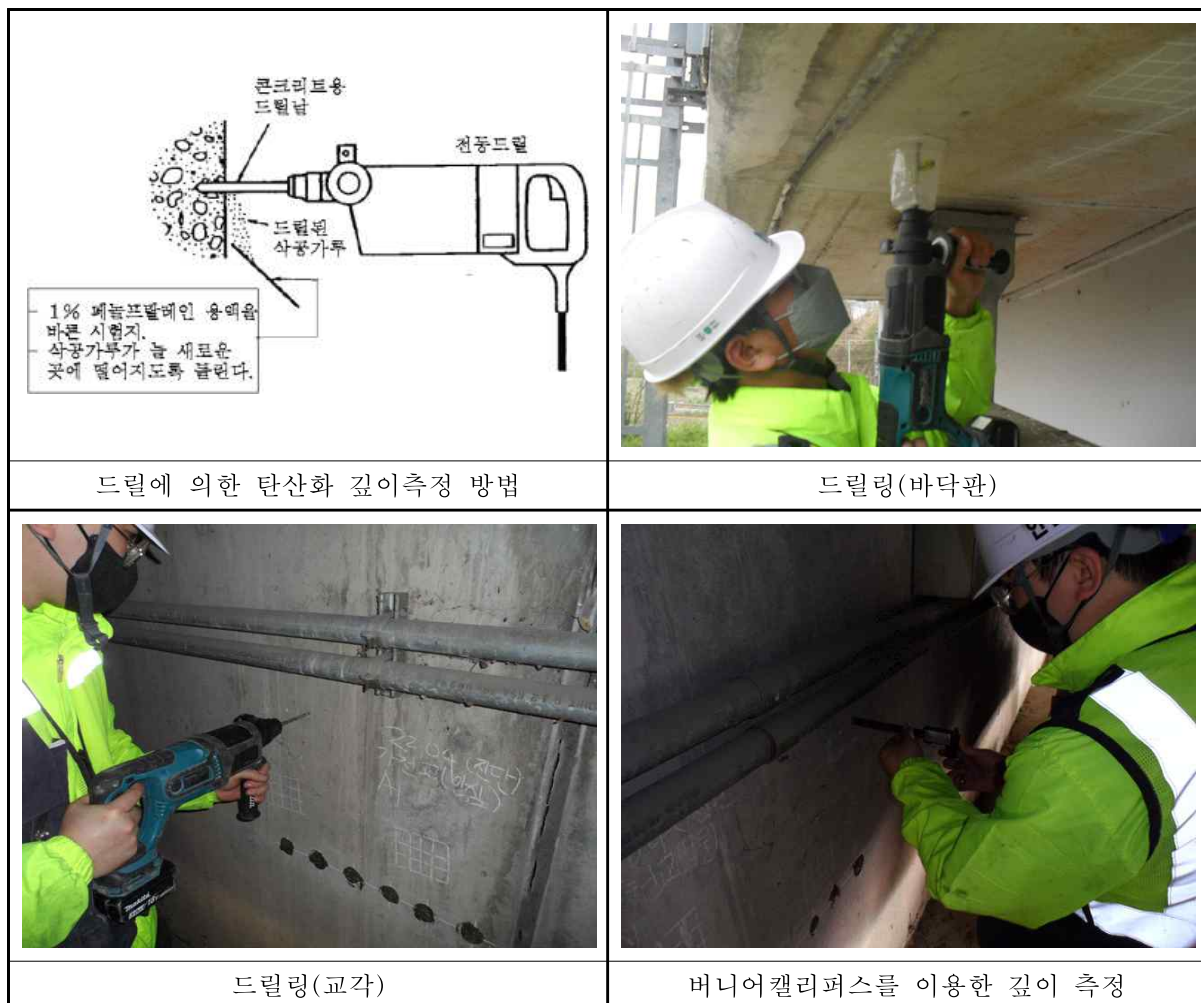
<그림 3.12> 드릴에 의한 탄산화 깊이 측정
