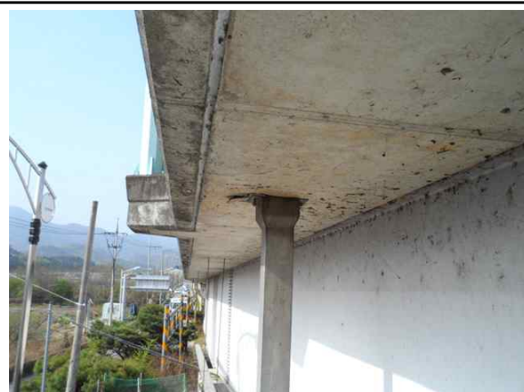
바닥판하면 캔틸레버부 전경(외측)
