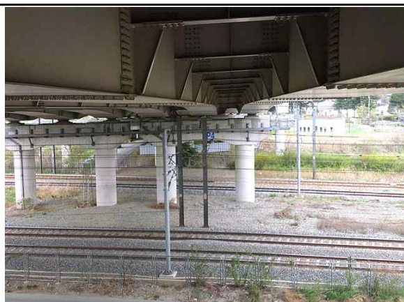
교각 P4 전경
