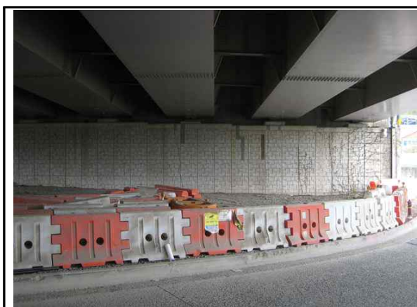
교대 A1 전경
