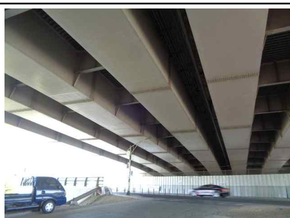
거더 외부(S2) 전경
