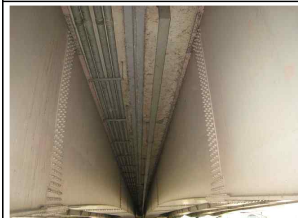
바닥판하면 캔틸레버부 전경(내측)
