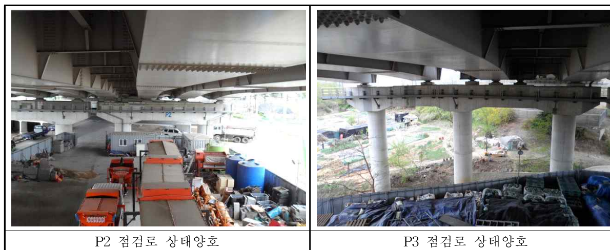
<표 3.28> 범물방향 점검시설 외관조사 결과
