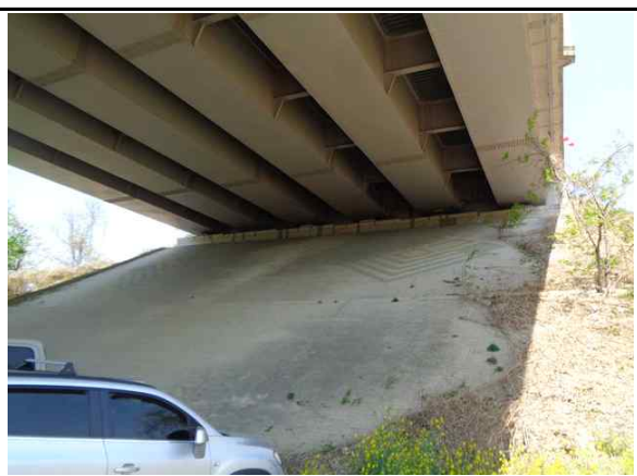
교대 A2 전경
