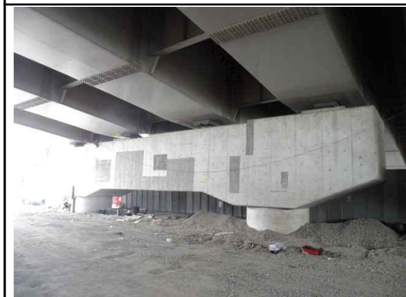
교각 P1 전경
