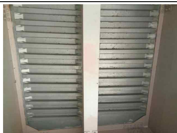
바닥판하면 데크플레이트 전경
